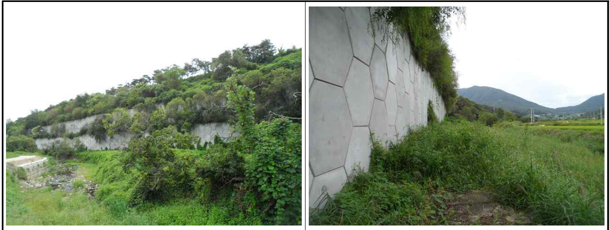
【사진 2.3.1】 지반, 기초부 전경
