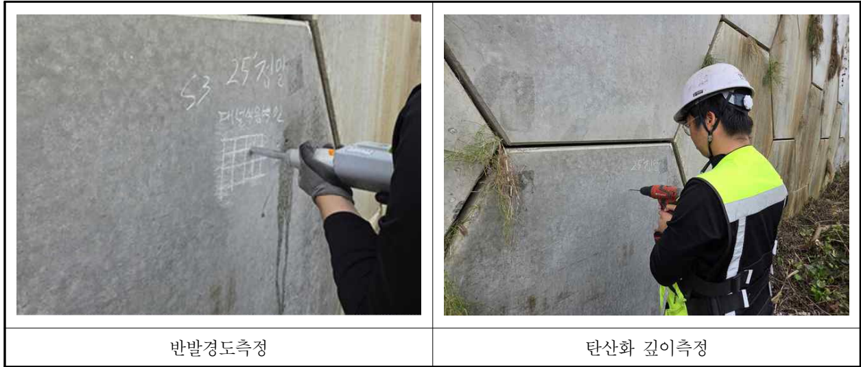
【사진 2.4.1】 재료시험 조사 전경
