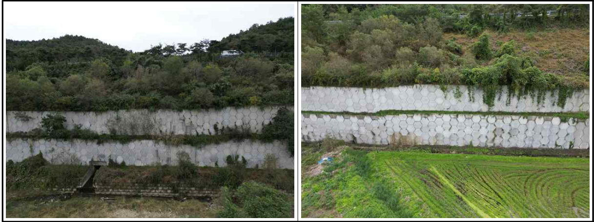
【사진 2.3.2】 전면부 전경
